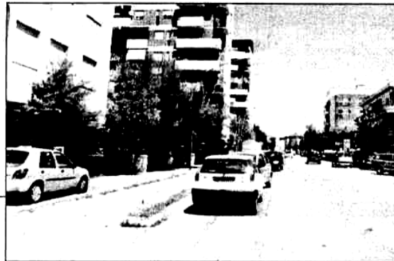
Una delle palazzine in via Amiterno potrebbe essere dichiarata inagibile per rischio di cedimento e di incolumità in quanto ci sarebbero grossi problemi strutturali secondo una perizia della Procura. Una cinquantina di famiglie che abitano l'immobile rischia di essere sgomberata
