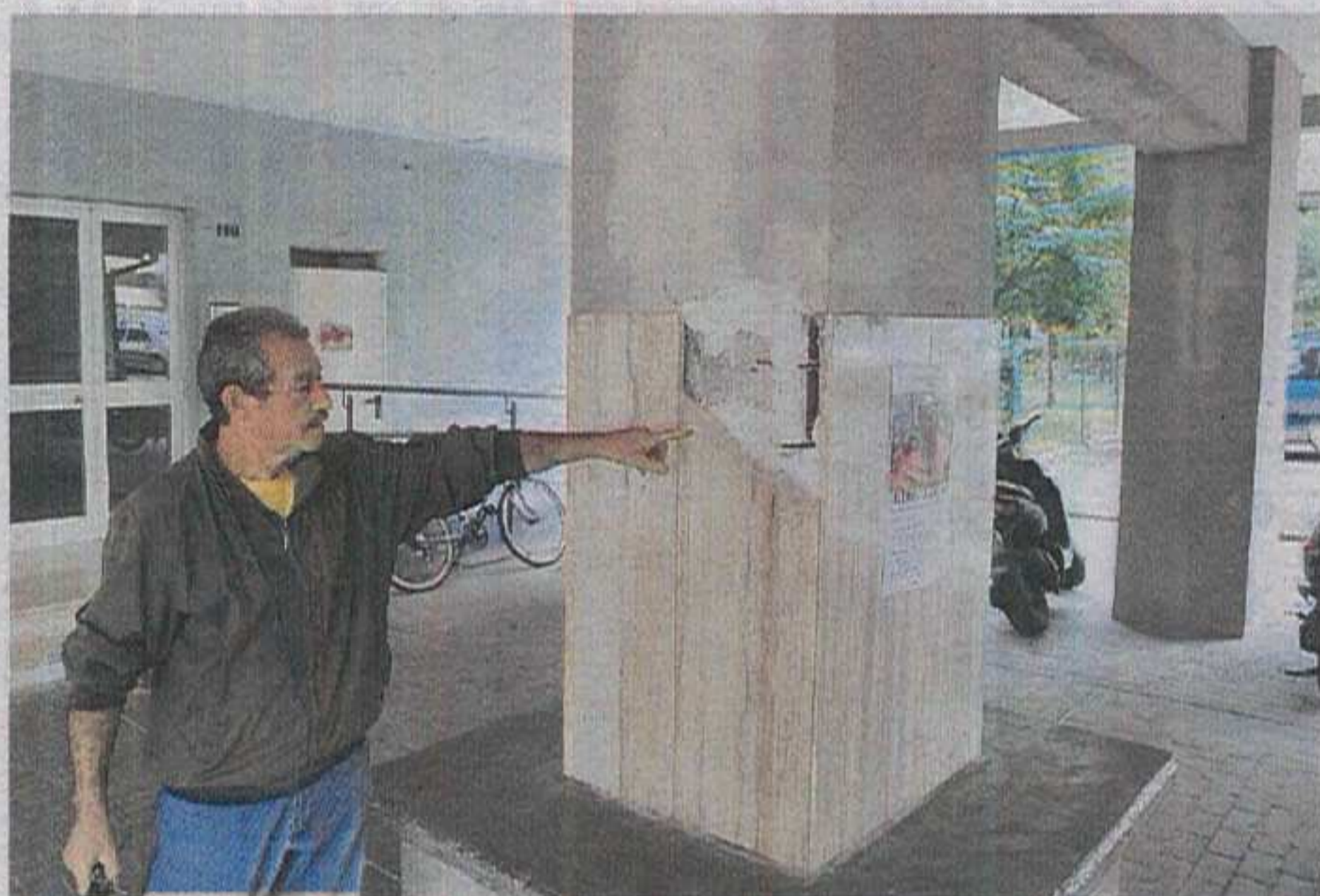
Uno dei pilastri lesionati nella palazzina 4 (foto Michele Camiscia)
