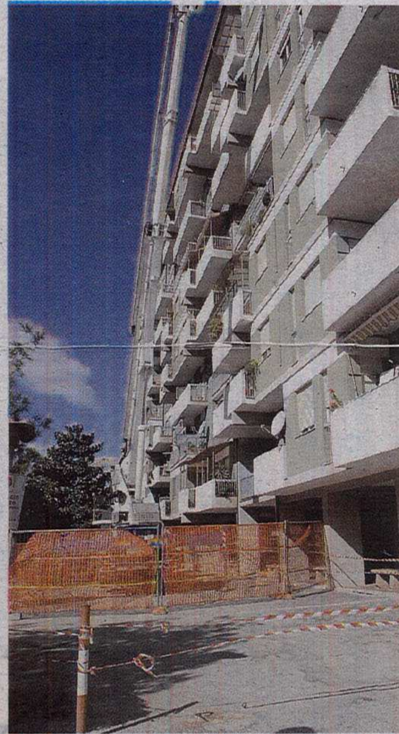
La palazzina numero 4 sottoposta a lavori urgenti
