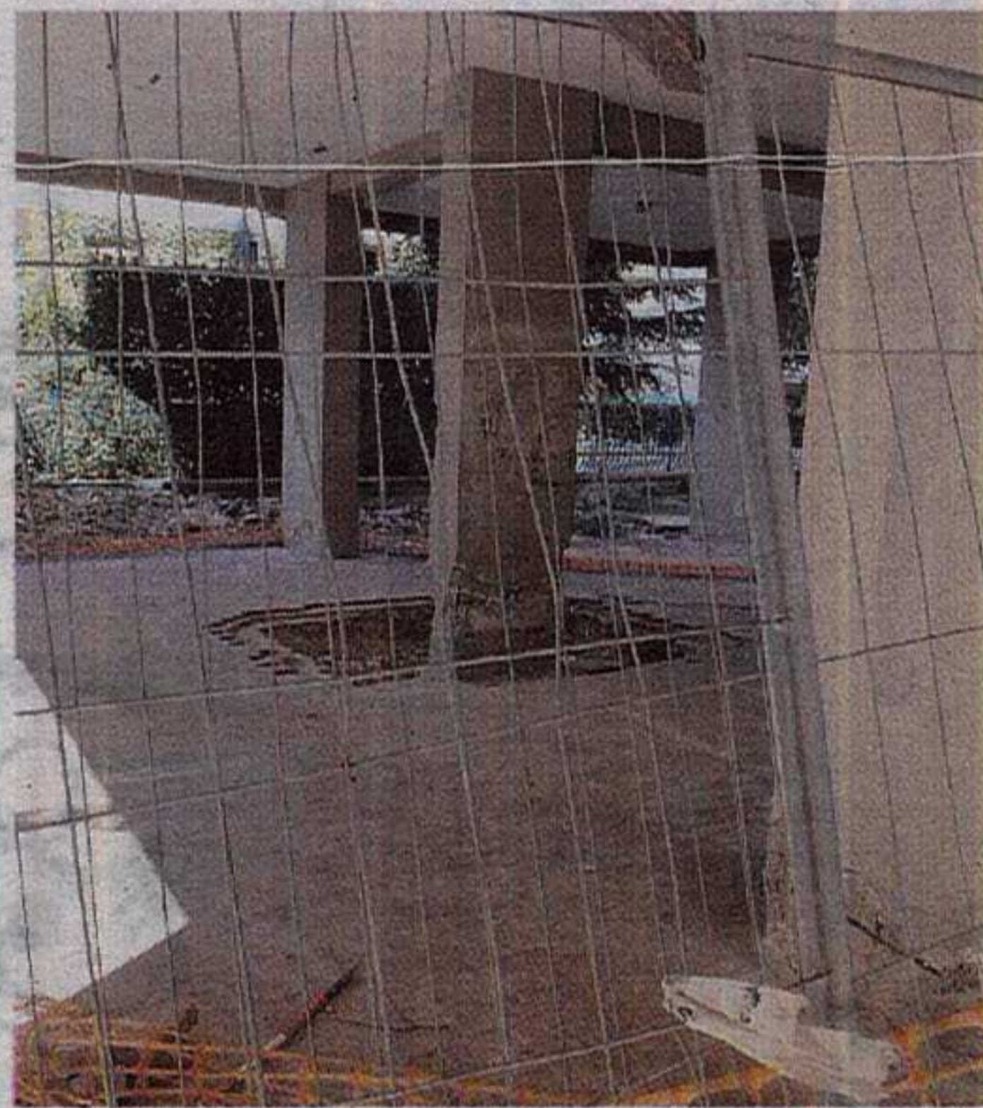
Un cantiere in via Amiterno
